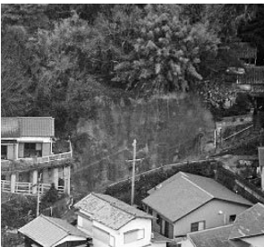
（図16）住宅地内の危険な竹藪
